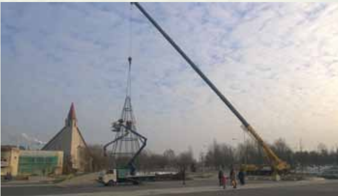
13,5 m aukščio eglės karkaso montavimo epizodas
