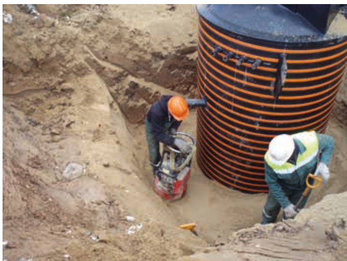
Nuotekų siurblinės statybos darbai
