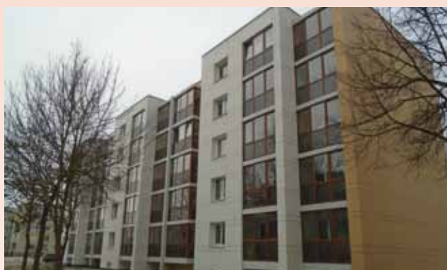
Ramučių g. 2, Naujoji Akmenė, apšiltintas ventiliuojamomis plokštėmis
