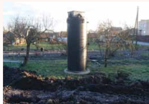
Sodų gatvės Naujojoje Akmenėje nuotekų siurblinės statyba
