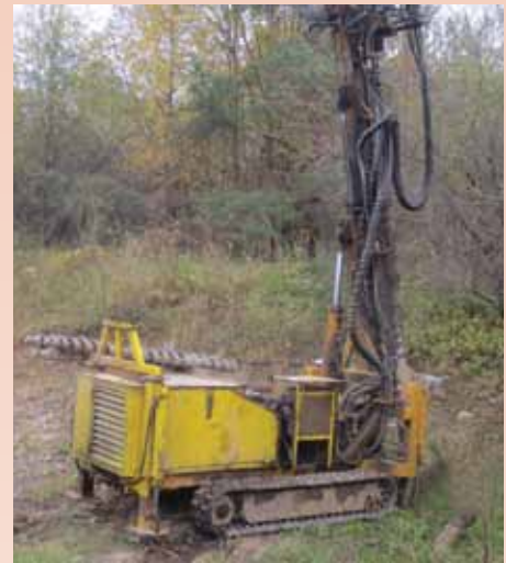
Įrengiami gręžiniai grunto mėginiams paimti
