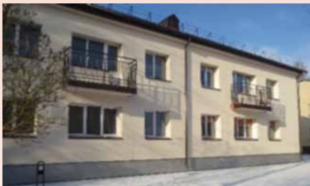
Bausko g. 1, Venta, apšiltintas aptinkuojant
